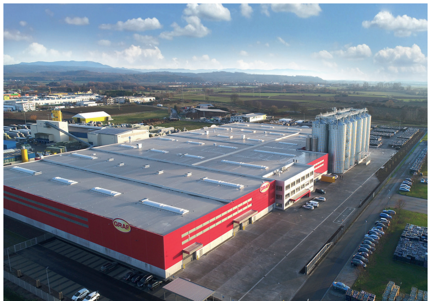
Bild 3. Schon von weitem gut sichtbar: das Graf Kompetenzzentrum Rohstoffe. Dort will das Teninger Unternehmen die Rezyklatrate auf 85 % bringen © Graf
